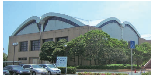
「老朽化が進む総合体育館」
